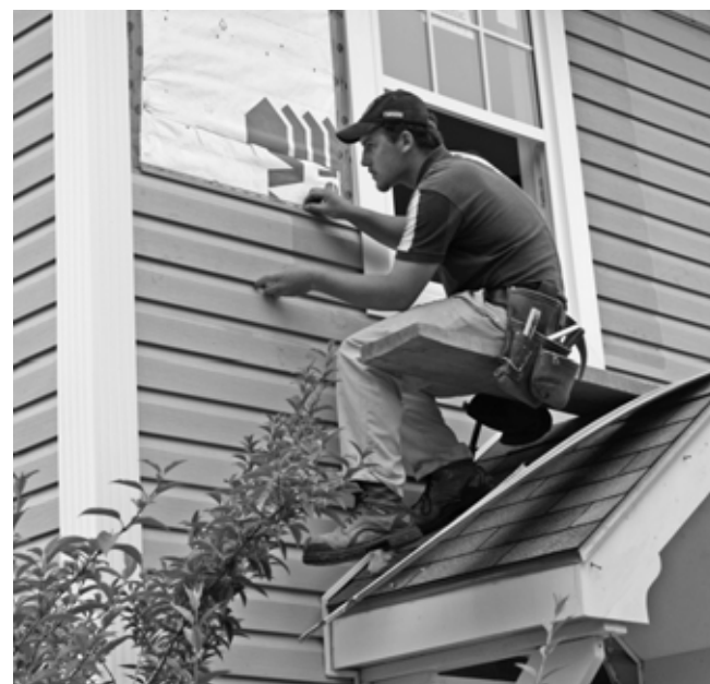
Andrew Wade de la construction Roscoe de Cambridge travaille sur le parement d'un mini-reno.
